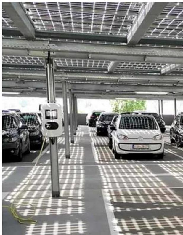
Abbildung 27: An einen Stützpfeiler montierte Ladesäule (Bildquelle: [www.hoermann-info.de](http://www.hoermann-info.de))
